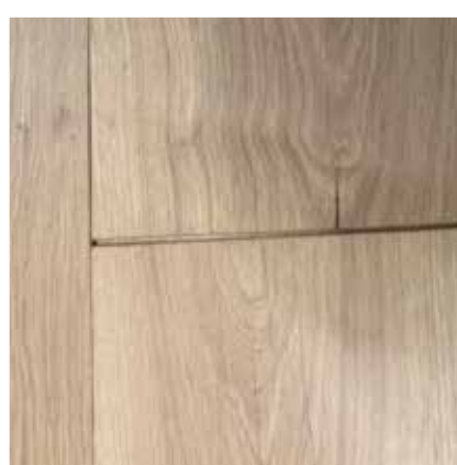
Spaccature e fessurazioni di testa.
