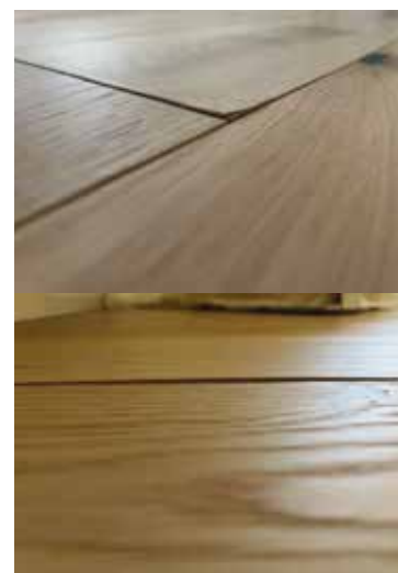
Sollevamenti perimetrali degli elementi.
